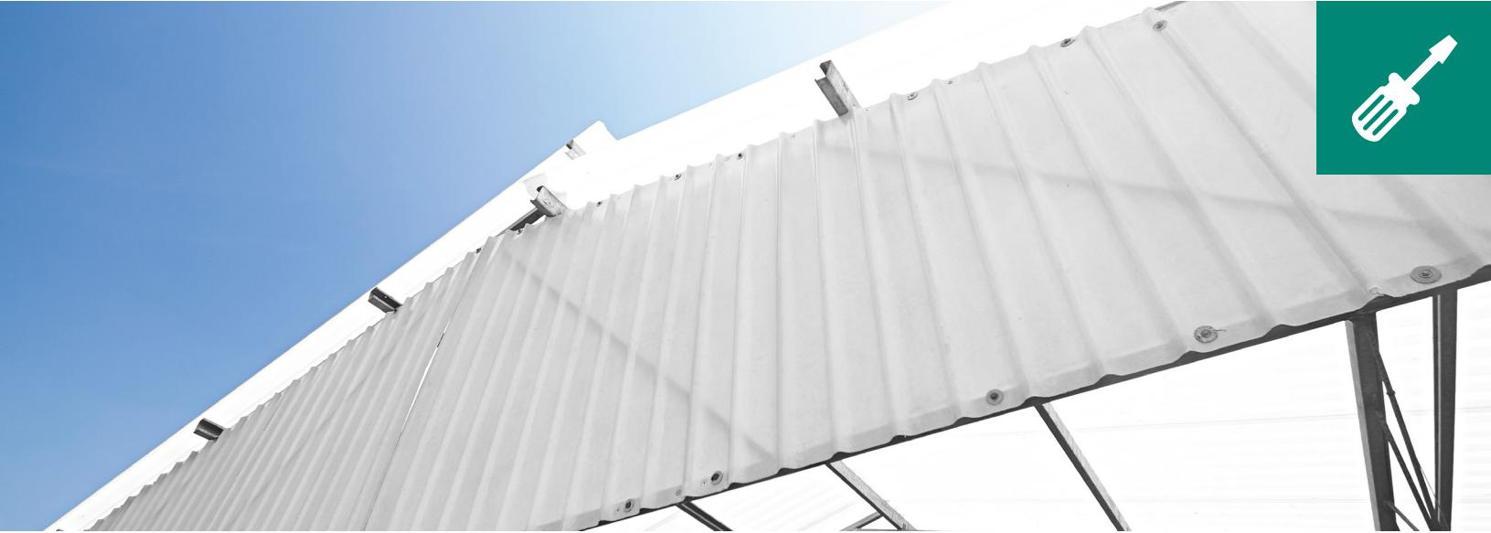
Se recomienda utilizar arandelas de acrílico de 1 ¼ de diámetro para tener una mayor superficie de contacto sobre el laminado y aumentar el espesor en el área de fijación.
