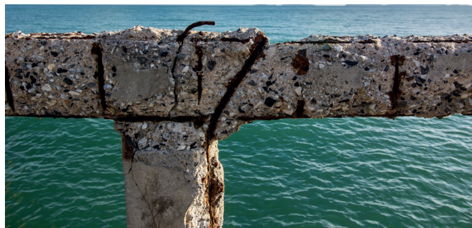
Estructura con exposición de varilla por corrosión.
